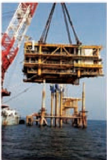
شکل ۵-۱۹: نصب رو سازه بگ سگو
