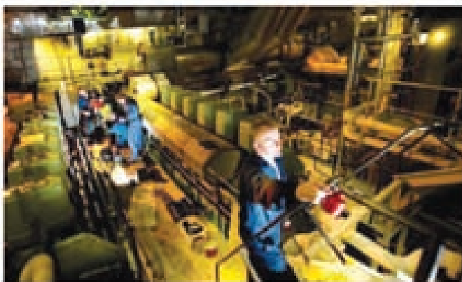
شکل ۲-۷: موتورخانه کشتی و مهندسین موتور در حال تعمیر موتور
