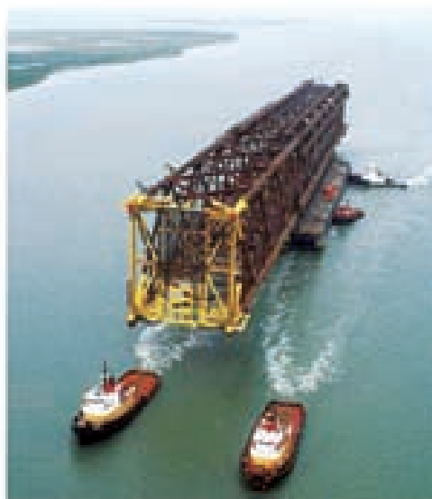
شکل ۵-۱۸: حمل پایه های بگ سگو به محل نصب با کشتی
